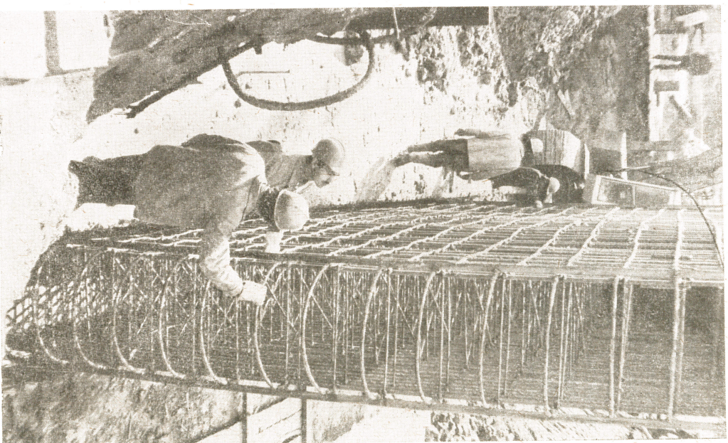
Строительство методом «стена в грунте» ведет бригада Н. Романовского
