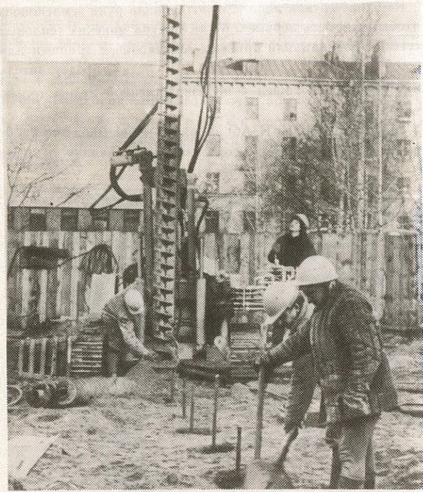
Устройство вибронабивных свай
