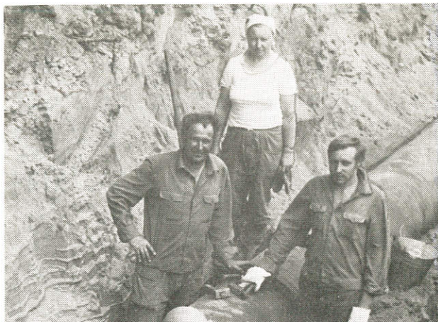
На строительстве водопровода Боровляны работает бригада В. Ермолицкого. Фотография на память
