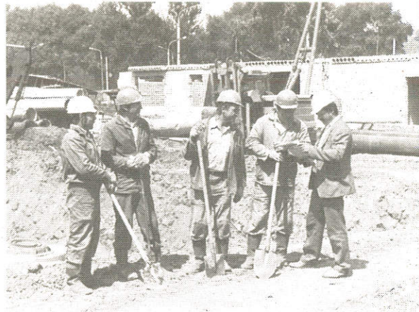
У прораба В. Щечко и членов бригады Н. Рыбинского есть немало сложных вопросов на перекладке подземных сетей в районе будущей станции метро "Молодежная"
