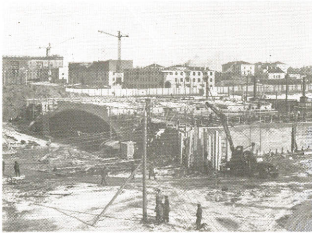
Строительство железобетонного моста через реку Свислочь
