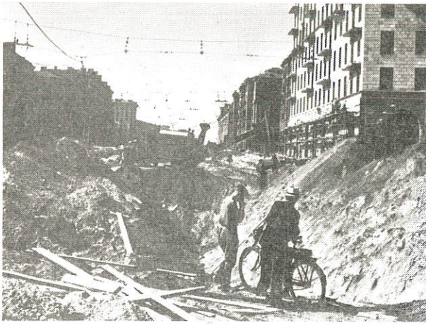
Прокладка подземных коммуникаций на площади Я. Коласа
