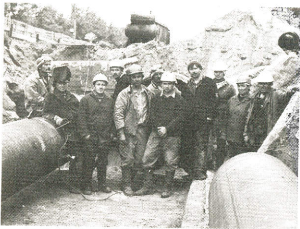
На реконструкции тепломагистрали № 5.
